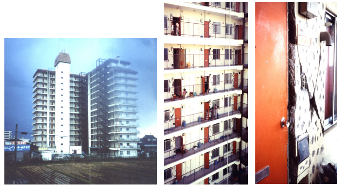
1978年宮城県沖地震で非構造壁に被害を受けた仙台市内のマンション賠償責任を巡る民事裁判が結審するまで10年を要した。
