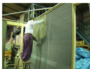
(d) モルタル下塗り
