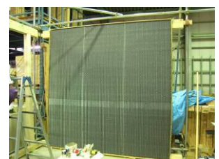
(c) メタルラスの施工
