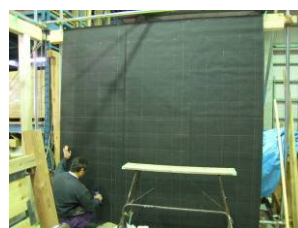
(b) 防水シートの施工
