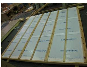
(a) 下地の施工
