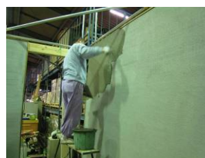
(e) モルタル上塗り
