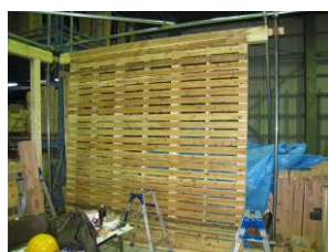
(a) モルタル塗り外壁の下地板の施工
