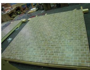
(b) 窯業系サイディング材の施工
