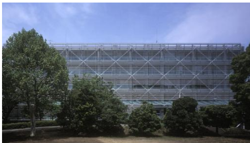
統合ファサードエンジニアリングによる耐震改修
