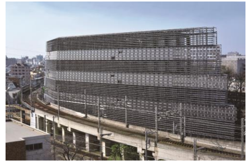
損傷制御設計を適用した低層環境エネルギー研究施設
