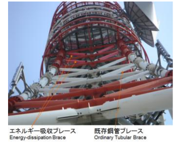
制振部材による電力鉄塔の耐震改修
