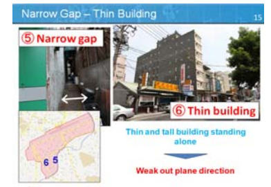
(e)建物間の狭い間隔・薄い建物
