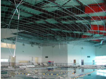
図1 大規模な天井落下被害の事例
