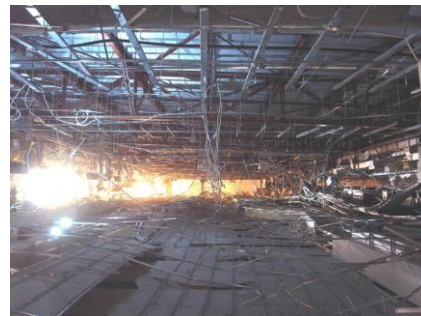
図1 大規模な天井落下被害の事例
