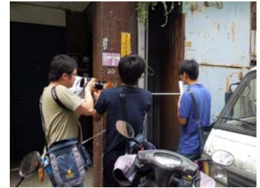
(b)建物の調査
