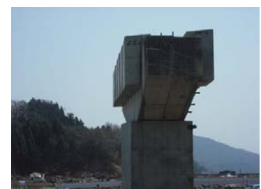
写真 6 沼田跨線橋 アンカーは直立状態で現存
