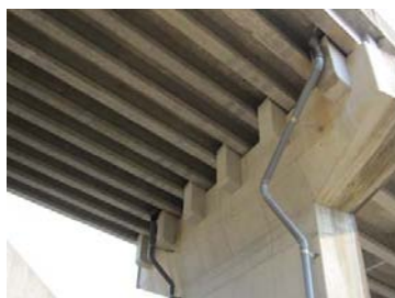
写真 2 鹿折高架橋 桁は連結済み、橋脚は巻立補強済み
