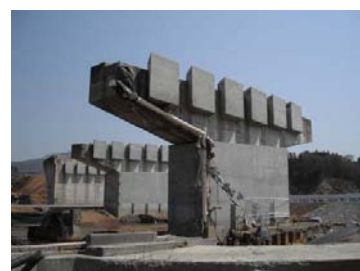
写真 5 沼田跨線橋 落下防止装置はほとんど無損傷
