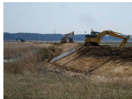
写真 2: 堤体の液状化により沈下した堤防（涸沼川 左岸 8.0k 付近、茨城県東茨城郡茨城町下石崎。左: 県管理区間の被災状況、右: 国管理区間の緊急復旧状況（2011 年 4 月 13 日撮影）
