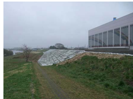
写真 1: 基礎地盤の液状化により沈下した堤防（江合川 右岸 26.8k 付近、宮城県大崎市古川福沼。左: 対岸から撮影した緊急復旧前（2011 年 3 月 14 日撮影）、右: 緊急復旧後（2011 年 4 月 22 日撮影）
