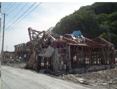
写真5 津波で破壊された鉄骨造建物
