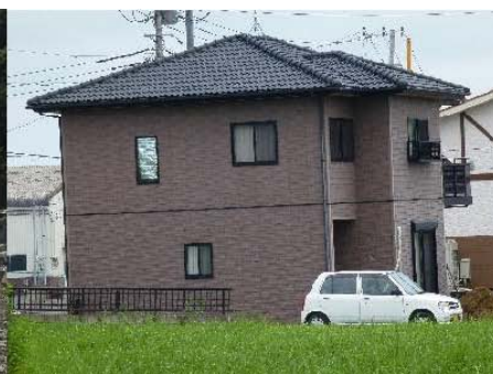
写真6 液状化で傾いた住宅
