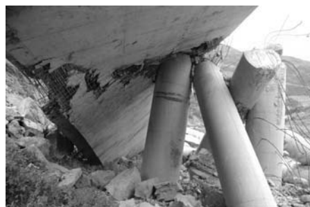
写真7 地震による倒壊区間
