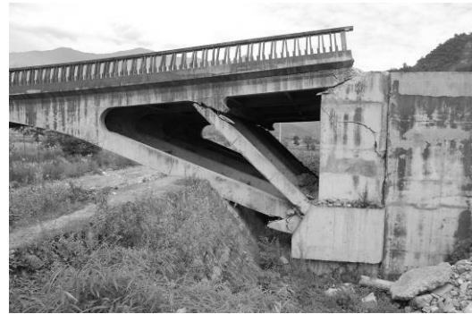
写真16 脚と斜材の被害 (A1との固定部)
