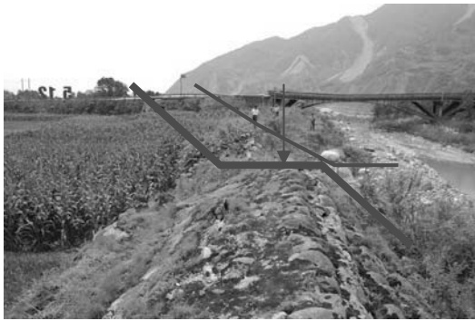
写真17 左岸側護岸から取付け盛土に向かう断層
