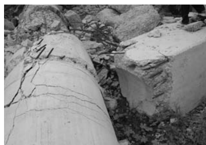
写真9 分離した脚と横梁の接合部
