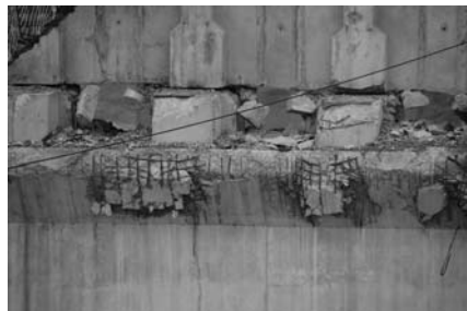
写真3 桁が最初に落下した側の支承部
