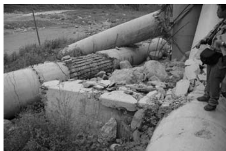
写真8 地震による橋脚の倒壊
