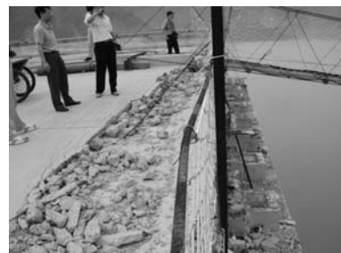
写真4 連続床版の被災
