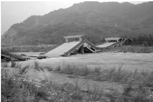
写真 1 3 小魚洞橋の落橋
