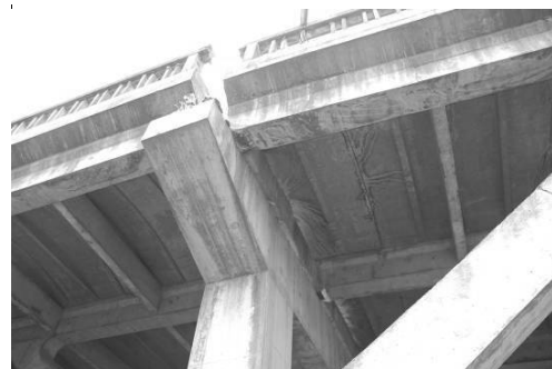
写真 1 4 落下寸前の橋脚 2 上の桁 2
