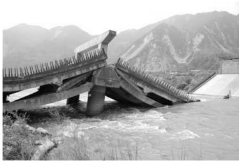
写真15 橋脚3上における桁3, 4の落橋
