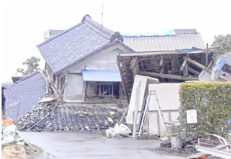
捻れ振動により1階が倒壊した木造住宅
