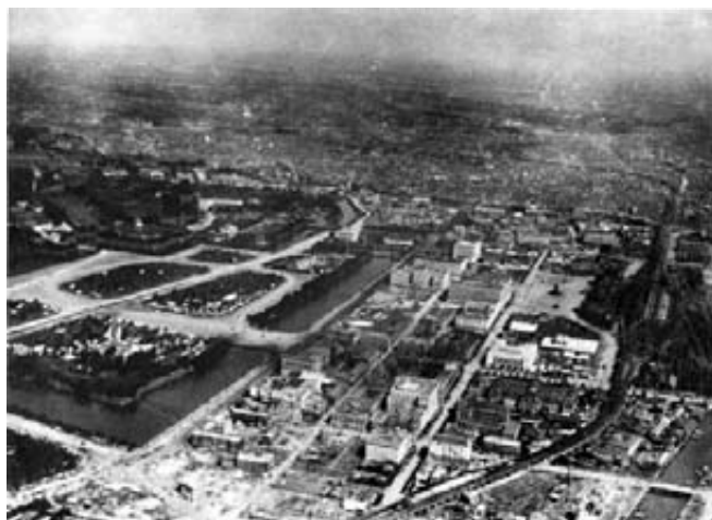
関東大震災(大正12年9月1日)丸の内方面の惨状
