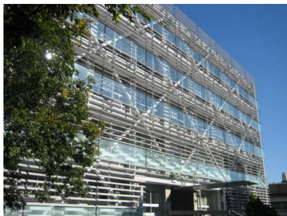
エネルギー吸収部材による耐震改修
