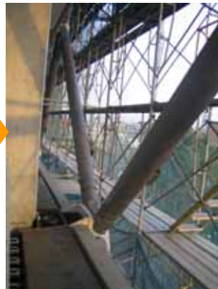
図8：ブレース定着部の施工状況
