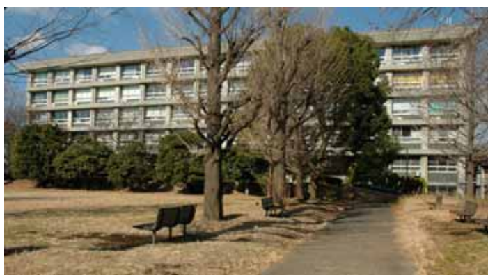
図1: 補強前の緑ヶ丘1号館
