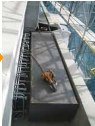
図8：ブレース定着部の施工状況
