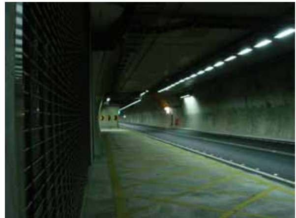
写真 - 5 雪山トンネル内（高速道路脇の空気循環施設前）
