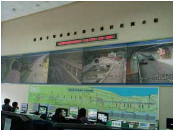
写真 - 4 雪山トンネル管理センター
