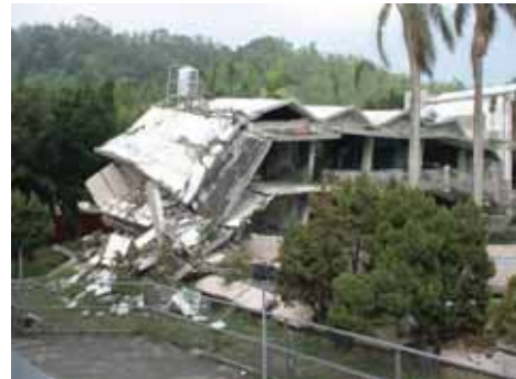
写真 - 8 完全に崩壊した学校
