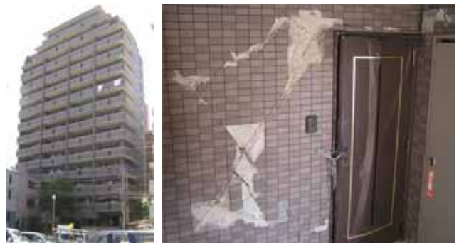
写真6 高層マンションの被害状況(中央区今泉2)
