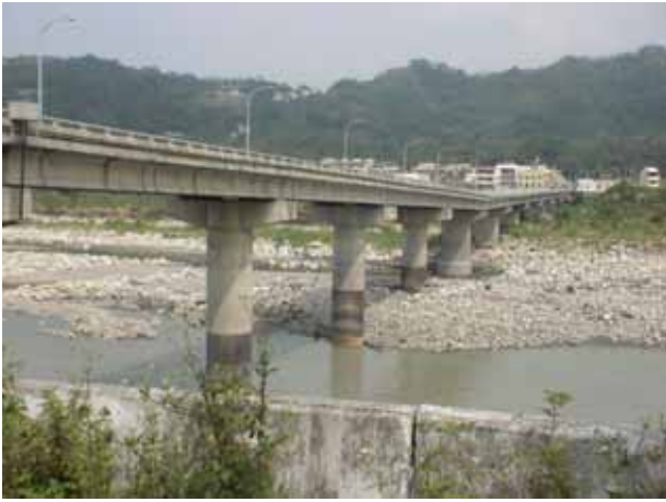
写真 - 13 石岡ダム下流の大甲川に架かるコンクリート橋(被災後に主桁のみを補修して使用しており、途中で縦断勾配が大きく変化している)
