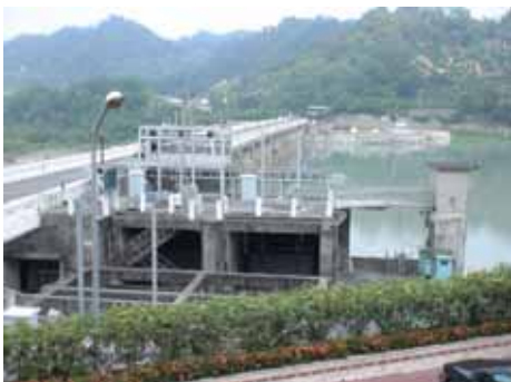
写真 - 9 石岡ダム（写真奥に地震被害が見られる）
