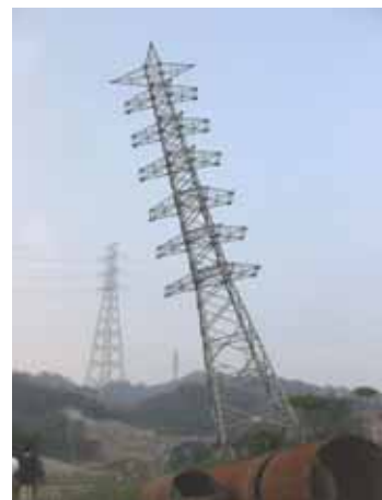
写真 - 12 大きく傾いた送電用鉄塔
