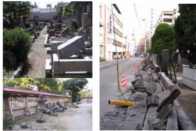
写真4 被害の大きかった警固断層東側の墓石・石灯籠等 今泉2長円寺(左上) 天神2 警固神社(左下) 天神3 安国寺(右)
