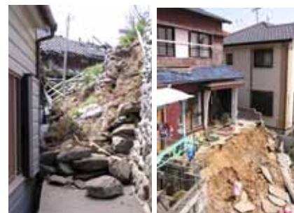
写真 3 玄界島の被災状況(主な被害は石垣と屋根瓦)
