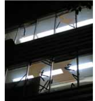
写真 2 地震当日夕刻までに片付けられた路上のガラス片と破損した窓ガラス(上)。下は建物全体に防御ネットを張られた地震翌朝の福岡ビル。
