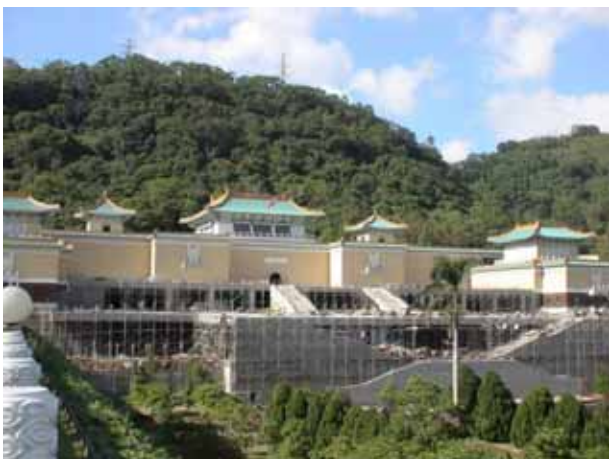
写真 - 17 故宮博物館(免震を取り入れた耐震工事中)
