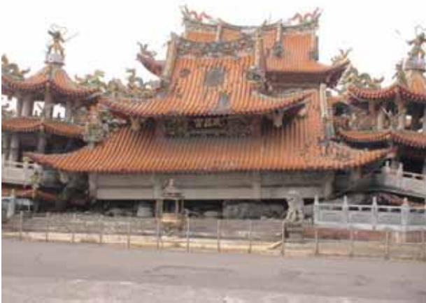
写真 - 15 集集地震震源地に近い完全に崩壊した中国式寺院(意図的に被災のままとしている)
