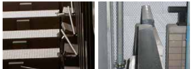
写真7 高層マンションの被害状況(中央区薬院3)
