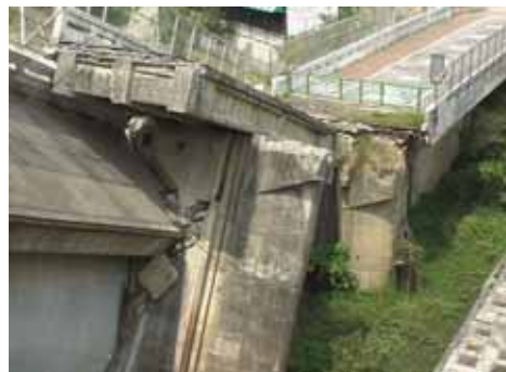
写真 - 10 断層の大変形によってダムの一部が破壊
