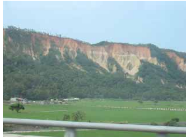
写真 - 14 台北から台中に向かう高速道路沿いの至るところで見られた斜面崩壊の状況
