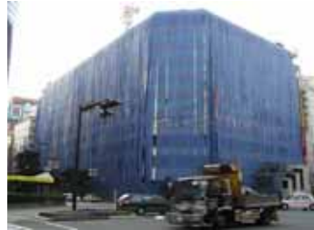
写真 2 地震当日夕刻までに片付けられた路上のガラス片と破損した窓ガラス(上)。下は建物全体に防御ネットを張られた地震翌朝の福岡ビル。
