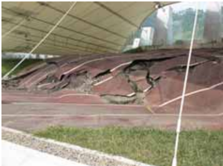
写真 - 7 大きく隆起した学校内の陸上のトラック
