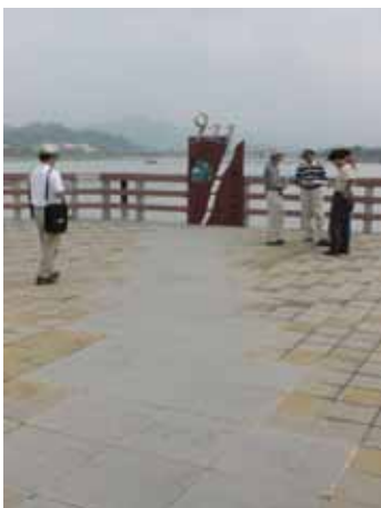
写真 - 11 ダムの被災部を利用したポケットパーク（断層に沿った模様が見られる）
