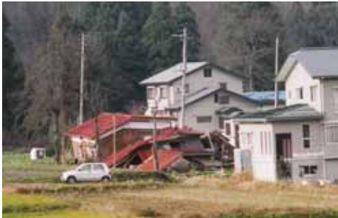
写真1 木造住宅の層崩壊
