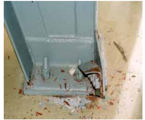
写真10 プレースの破断と柱脚の回転変形 (屋内体育館)
