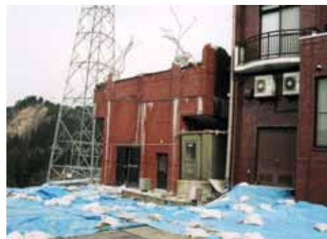
写真14 がけの崩壊に伴う建物の不同沈下
