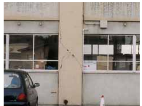
写真6 柱のせん断破壊（校舎）
