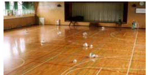
写真11 照明の落下 (屋内体育館)
