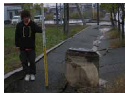
写真-7 マンホールの浮上り(小千谷市桜町)
