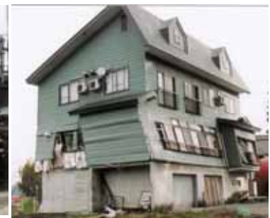
写真3 併用構造住宅の被害
