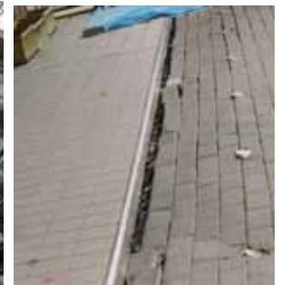
写真13 修繕しやすく作った免震病院の入口
