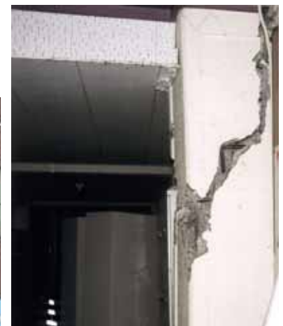
写真15 不同沈下による柱のせん断破壊 (校舎)
