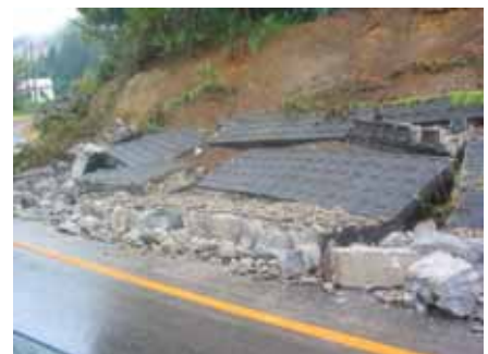
写真-4 ブロック積み擁壁の崩壊
