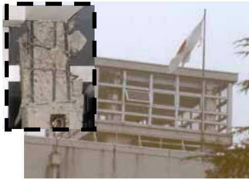
写真9 4本柱純ラーメン構造のペントハウスと柱の被害詳細
