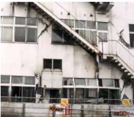
写真4 柱のせん断破壊（病院）
