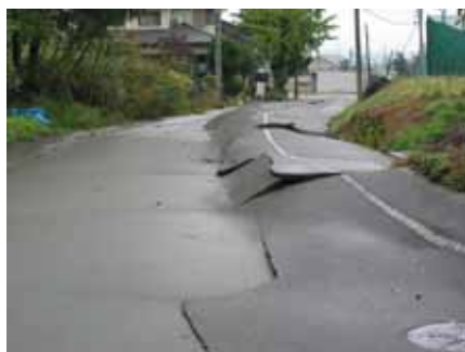
写真-2 盛土法尻付近
