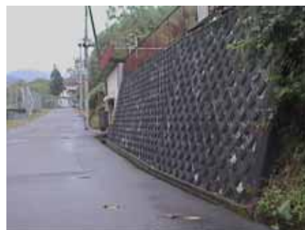
写真-3 道路を挟んで対面の切土斜面
