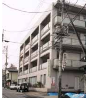
写真12 免震建物全景 (病院)
