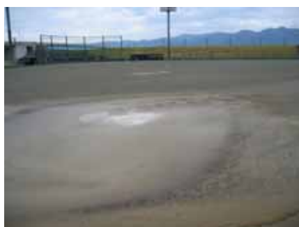
写真-5 越路町河川公園野球場の噴砂跡
