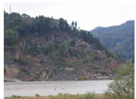
写真-1 妙見堰の斜面崩落現場
