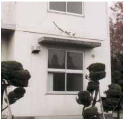
写真8 梁のせん断破壊 (校舎)
