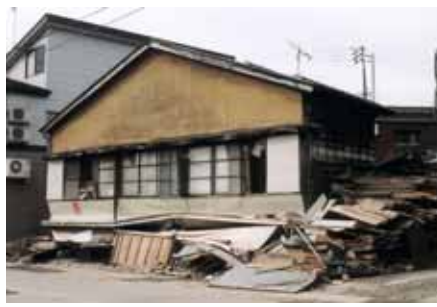
写真2 木造住宅の層崩壊
