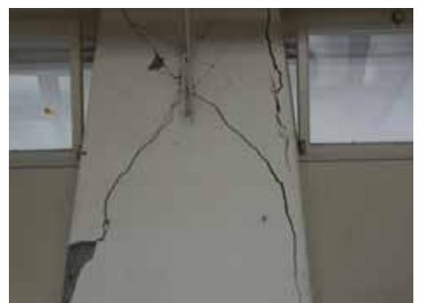
写真7 極短柱のせん断破壊（校舎）
