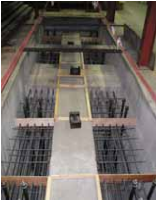
図2 基礎工事状況 (アンカー配筋、コンクリート打設)
