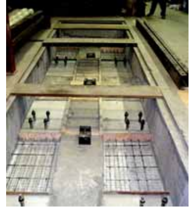
図2 基礎工事状況 (アンカー配筋、コンクリート打設)
