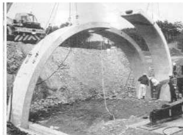
既設パネルを用いたトンネル工法
