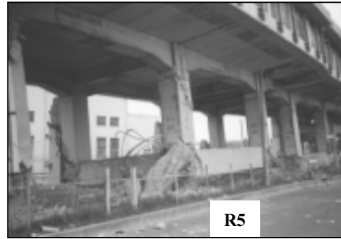
(b) Hansui R5 Viaduct
