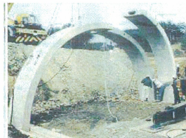
既設パネルを用いたトンネル工法
