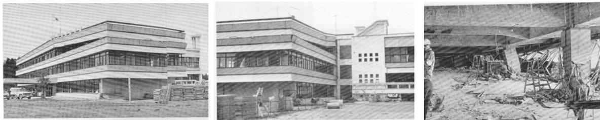
写真2 1968年十勝沖地震による「むつ市役所」の被害
