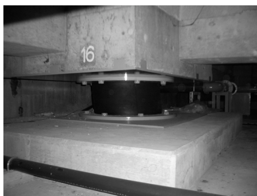
写真3 小千谷市の免震建物
