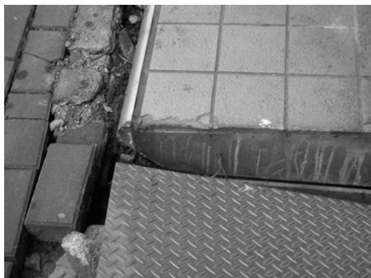
写真2 小千谷市の免震建物
