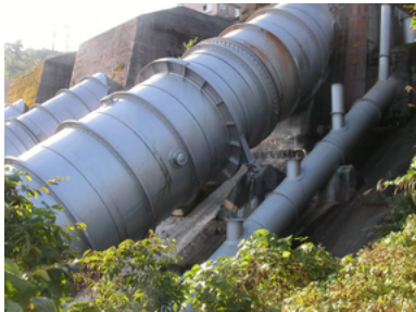
発電所の送水管は 5 本のうち中央の 1 本を除く 4 本からの漏水が認められた。中央は、発電 所の上の調整池で、28 日には水は抜かれていた。写真の左奥に見える対岸の堤防の一部は 大きく滑っていた。右は発電施設の一部で碍子の一本が転倒している。
