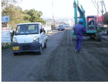
左は山辺橋の西詰め、右は東詰めの様子。橋台部分の裏込め土が滑って大きな段差ができて いる (28 日朝撮影)。中央は、28 日夕方の西詰めの様子で、自動車がスムーズに通れるよう に大量の砂利を入れて段差が埋められている。
