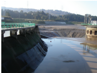
発電所の送水管は 5 本のうち中央の 1 本を除く 4 本からの漏水が認められた。中央は、発電 所の上の調整池で、28 日には水は抜かれていた。写真の左奥に見える対岸の堤防の一部は 大きく滑っていた。右は発電施設の一部で碍子の一本が転倒している。
