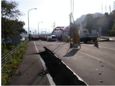
左は山辺橋の西詰め、右は東詰めの様子。橋台部分の裏込め土が滑って大きな段差ができて いる (28 日朝撮影)。中央は、28 日夕方の西詰めの様子で、自動車がスムーズに通れるよう に大量の砂利を入れて段差が埋められている。
