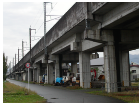
上越新幹線塩沢トンネルの北側出口付近。 (損傷なし)
