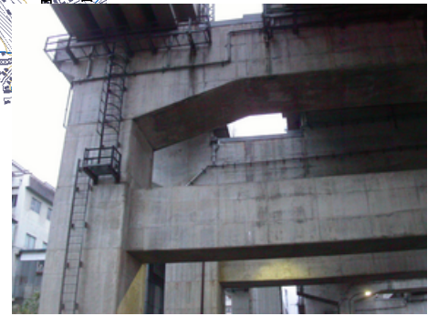
図 1: 上越新幹線越後湯沢駅の高架橋部分。損傷はない。
