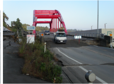
左は山辺橋の西詰め、右は東詰めの様子。橋台部分の裏込め土が滑って大きな段差ができて いる (28 日朝撮影)。中央は、28 日夕方の西詰めの様子で、自動車がスムーズに通れるよう に大量の砂利を入れて段差が埋められている。
