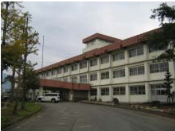
写真-2 大和中学校全景（北側構面）
