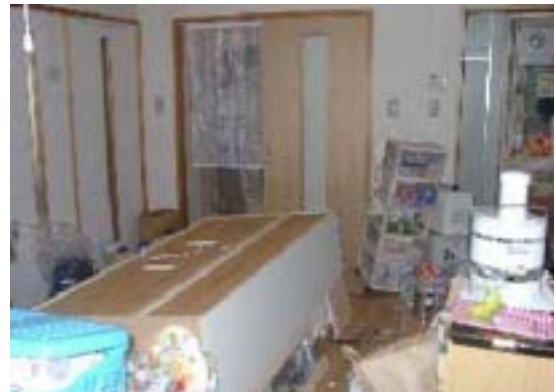
写真-23 住宅内部の家具の転倒 （新潟大学 加藤大介教授撮影）
