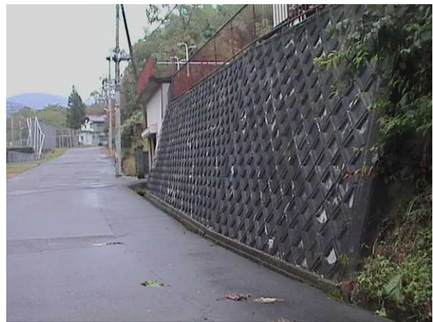
写真 6 道路を挟んで対面の切土斜面
