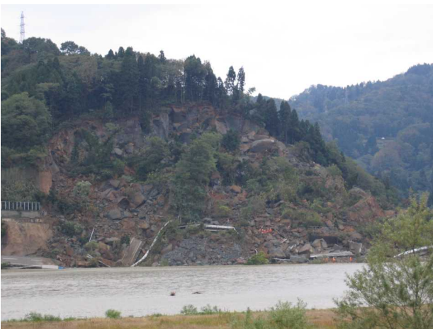
写真-12 妙見堰の斜面崩落現場
