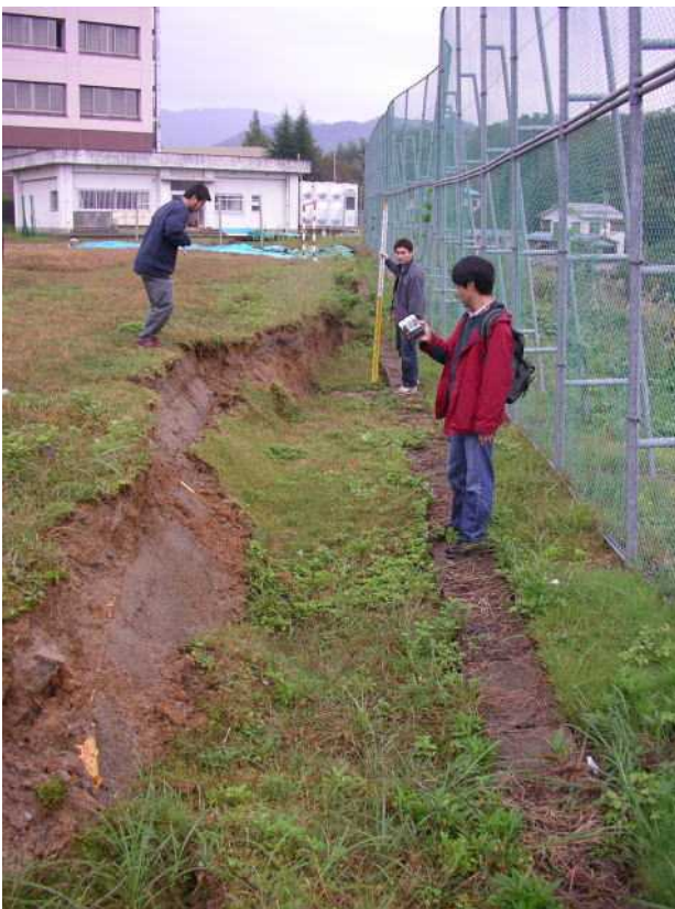
写真 4 長岡高専グラウンドのクラック
