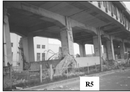
(b) Hansui R5 Viaduct
